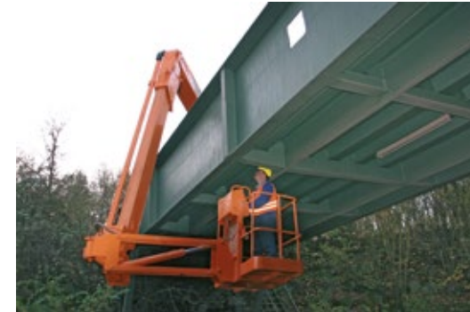
Prüfung von Gasleitungen unter einer Brücke in Hagen
