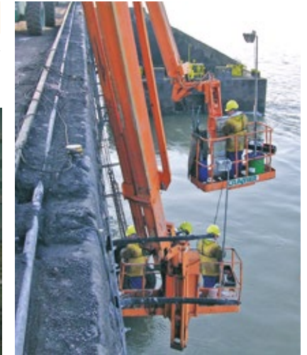
Montagearbeiten an einer Kaimauer am Rhein
